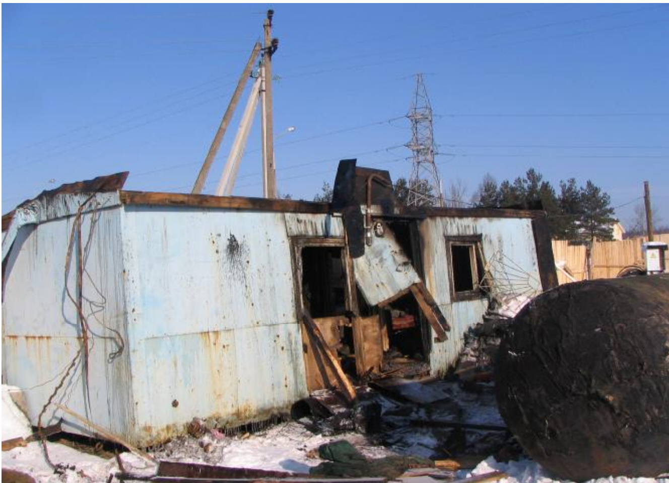
Пожар в бытовом помещении ЧТСУП "Полоцкая строительная компания" на стройплощадке промзоны «Коптево». Причина пожара неисправность печного отопления.
