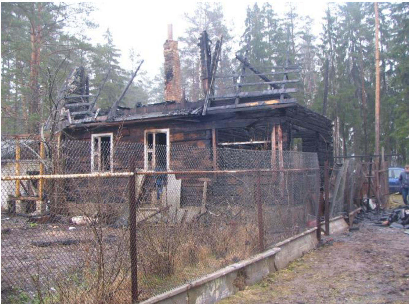
Пожар дачного дома СО «Энергетик». Причина пожара поджог .
